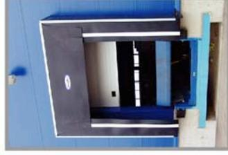
Грузовой док – оптимальный вариант для оборудования как небольшого склада, так и крупного грузового терминала. Док состоит из герметизатора проема (докшелтера), который сводит до минимума зазор между кузовом автомобиля и проемом склада, уравнивательной платформы (доквеллера) и герметичных секционных ворот.
