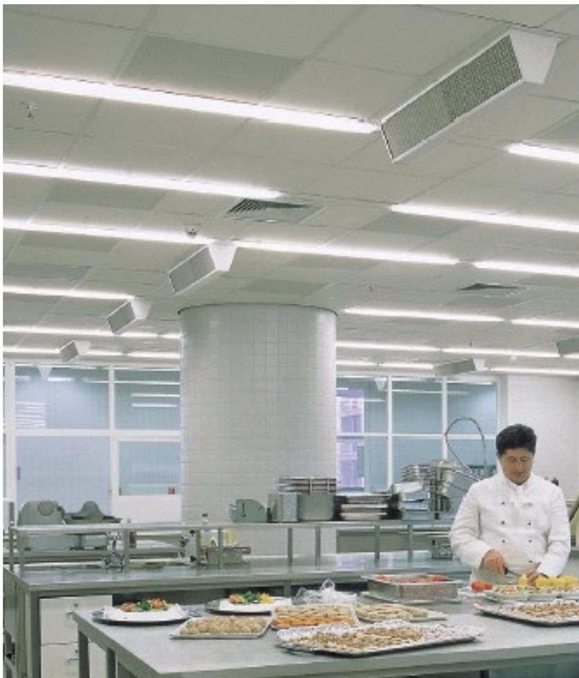
**Hygienic** - панель с водоотталкивающей поверхностью. Эта комбинация высокого коэффициента звукопоглощения и влагостойкости. Панели соответствуют высоким стандартам в отношении гигиены. Панели выдерживают различные способы очистки с применением мощных средств.
